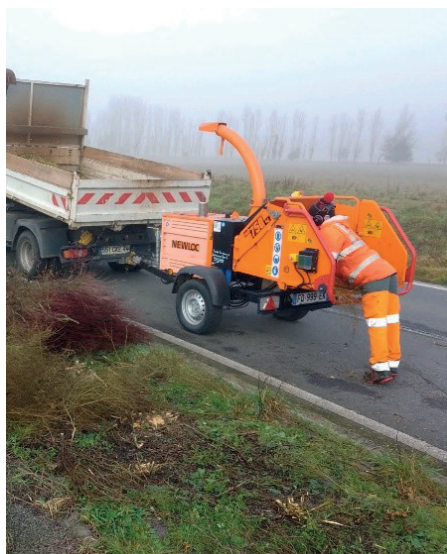
Travaux d'entretien zones d'activités
