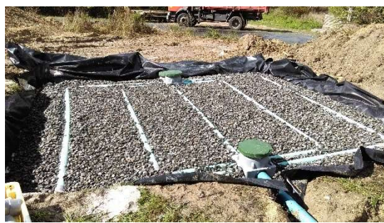
Fosse Toutes Eaux 3000L + Filtre à Sable Vertical Drainé 25m 2
